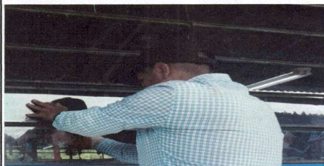
Foto 2: Sustitución de vidrios.
