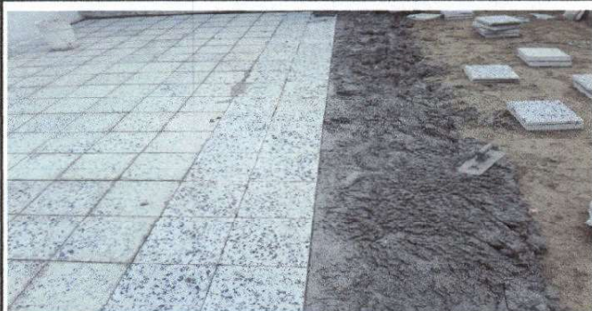
Foto 3: Sustitución de piso de torta por piso de granito.
