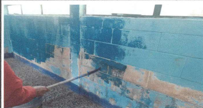
Foto 4: Pintura en muros interiores.
