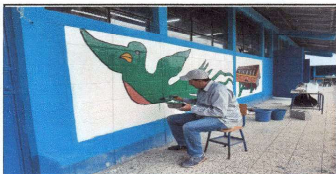
Foto 5: Pintura en muros exteriores.
