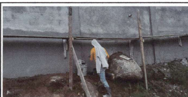
Foto 6: Reparando el muro perimetral.
