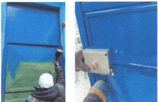
Foto1: Mantenimiento, aplicación de pintura y cambio de chapas de puertas.
